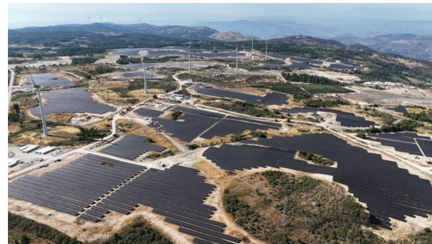
Figura 2: Parque Solar Fotovoltaico PV Sendim | Portugal
